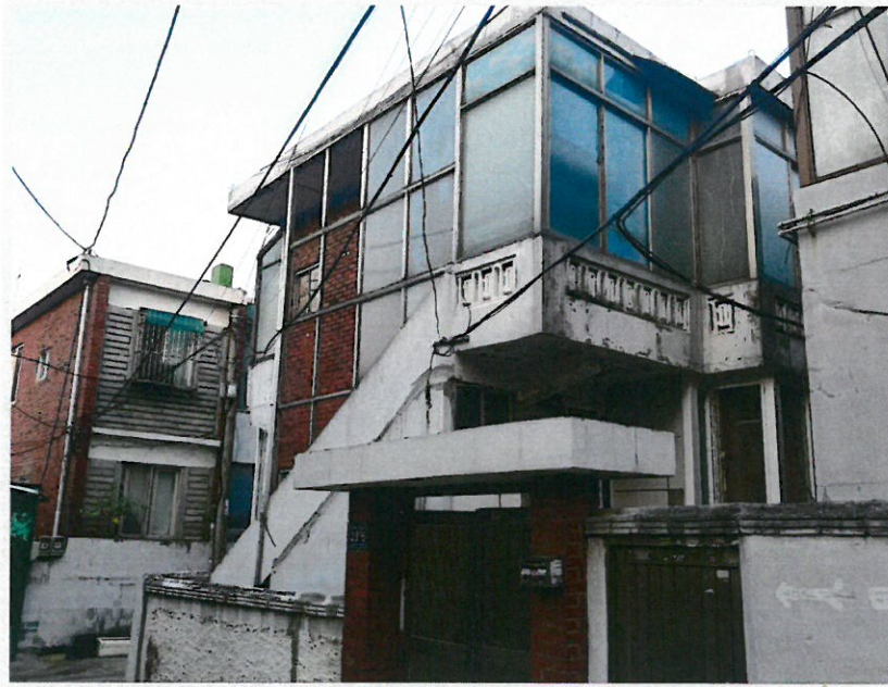
【본건 전경(남서측에서 촬영)】
